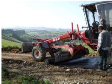
Pose du géotextile
