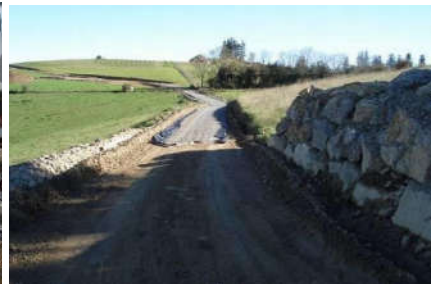
Mise en place du gravier
